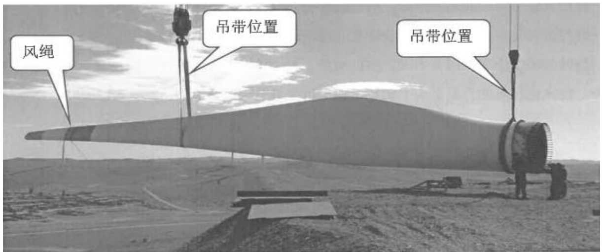
图 2 拆卸叶片吊带悬挂位置图
